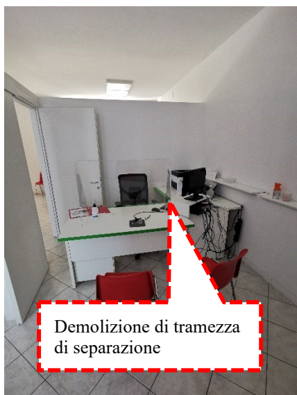
Fig. 14– Panoramica interna con indicazione delle difformità
